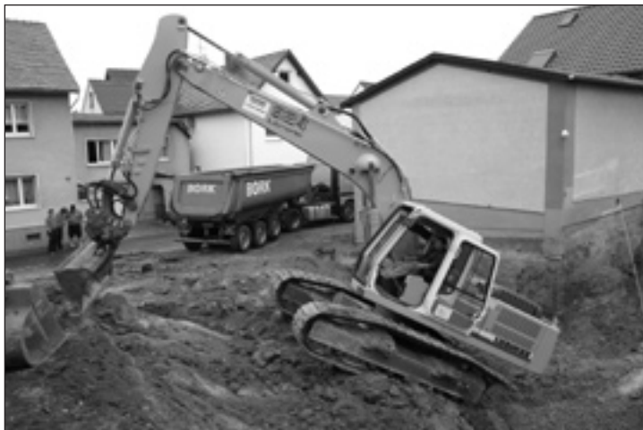
Baggerarbeiten an der Baugrube (Mai 2006)
