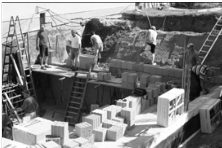
Baueinsatz am Kellergeschoss (Juni 2006)
